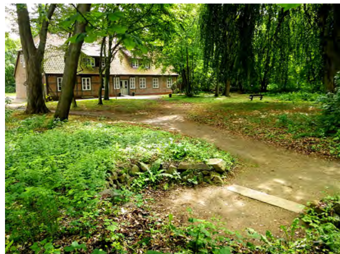
ABBILDUNGEN: Zugang Amtrichterhaus, Gebäuderückseite mit Sitzgrotte im Vordergrund
